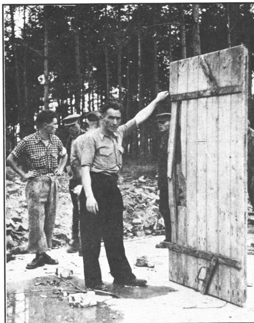
Document 2 : Porte étanche au gaz retrouvée presque intacte dans la partie ouest du crématoire V.
